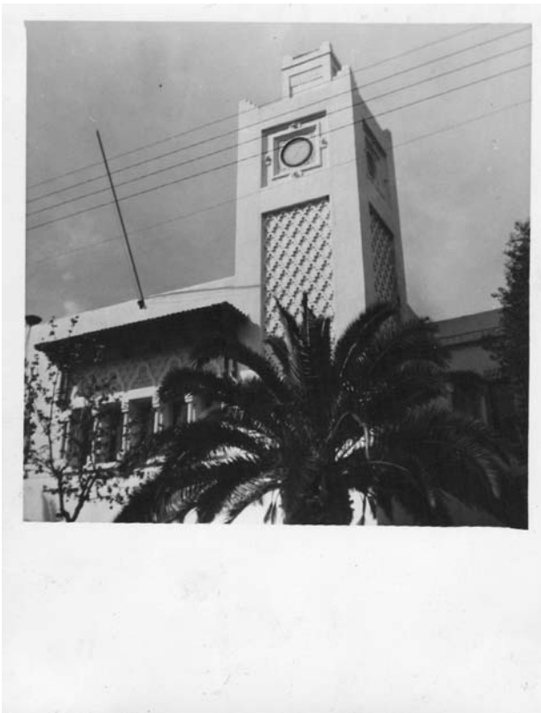
Le minaret de l'hôtel de ville de Duperré
