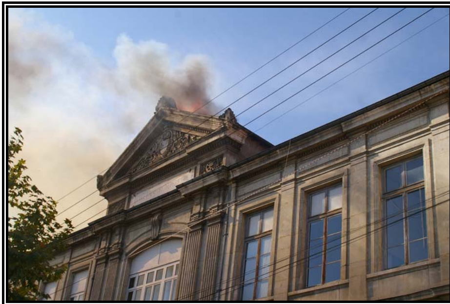
Le fronton de l'école supérieure. Cliché pris par Bernard Laroche pendant l'incendie du 20 octobre 2007
