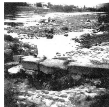
Fig. 10/. Pont de Saint-Rambert-sur-Loire. Clichés des piles en pierre avec pilotis. D'après RENAUD (J.), Bulletin Diana , 1945.
