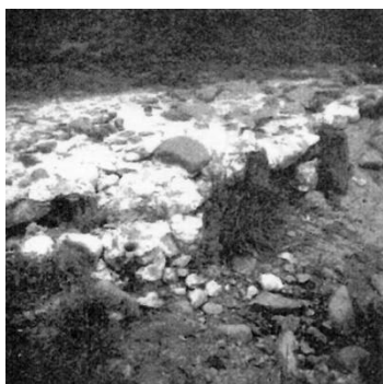
Fig. 10/. Pont de Saint-Rambert-sur-Loire. Clichés des piles en pierre avec pilotis. D'après RENAUD (J.), Bulletin Diana , 1945.
