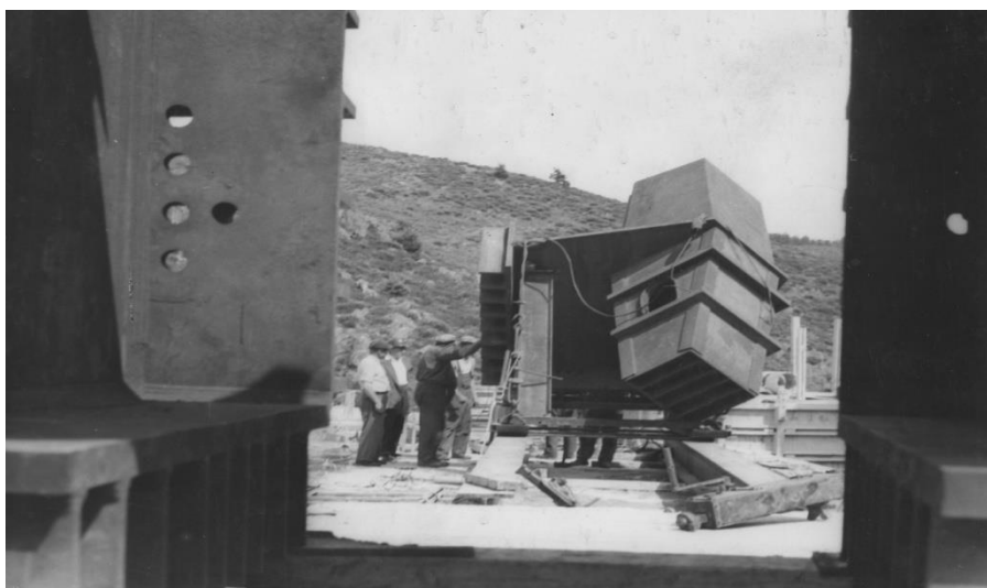
Poutre d'ancrage d'une vanne « évacuateur » de crue
