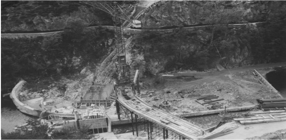
Vue générale depuis la rive droite
