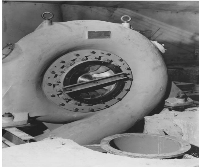
Roue de turbine d'un petit groupe
