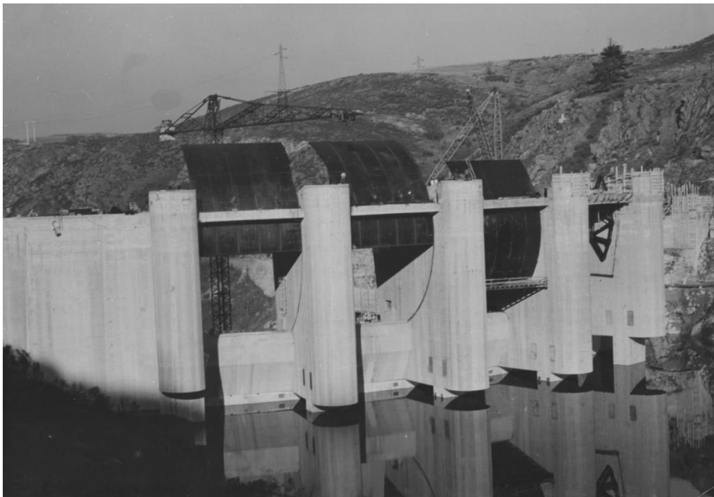
Vue du barrage depuis l'amont lors de la mise en eau
