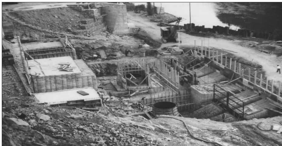
Vue générale sur les alimentations des groupes principaux
