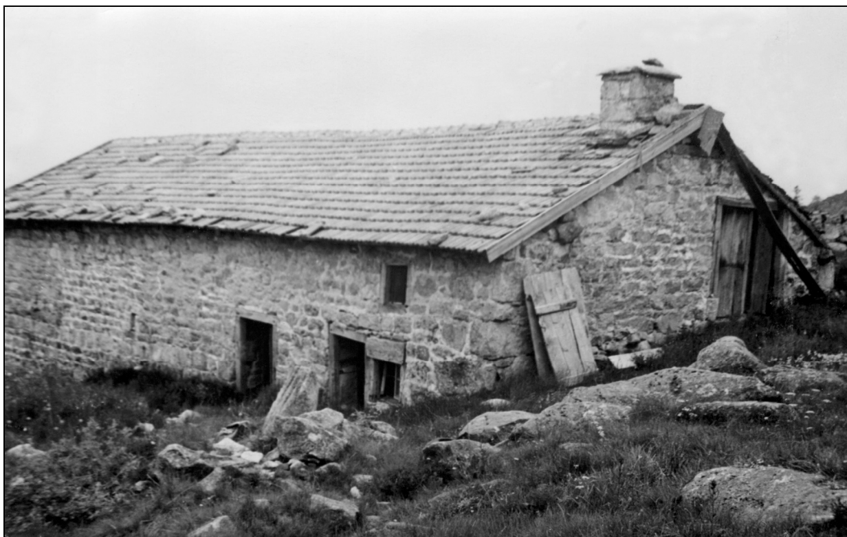
Cabane abandonnée. Deux portes d'entrée
