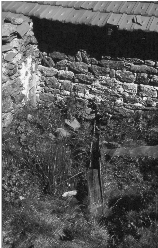
Conduit en bois
