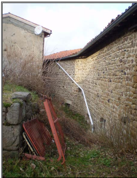
Emplacement probable d'une partie des anciens fossés de Sauvain en janvier 2007. Des bâtiments furent construits de part et d'autre du fossé lui-même, en s'appuyant sur l'escarpe et la contre-escarpe. Photographie de l'auteur ©
