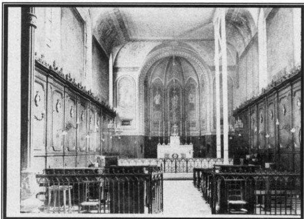
La chapelle en 1931 avant les travaux
