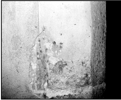
Ancien décor sous le crépi actuel (photographie n° 22)
