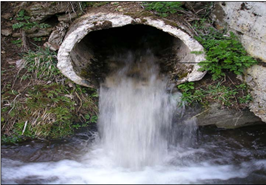
tuyau de sortie du bassin
