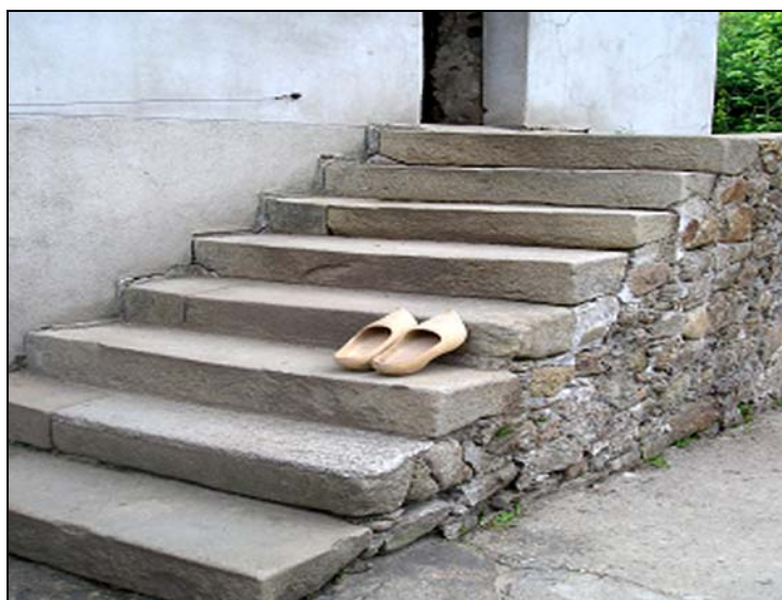
2 - escalier aux marches en pierre de taille
