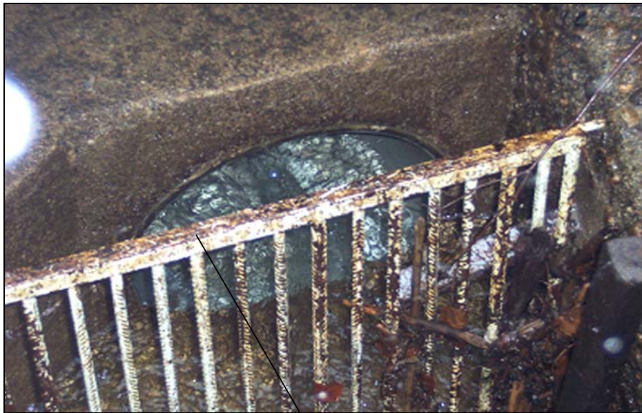
grille métallique à l'embouchure
