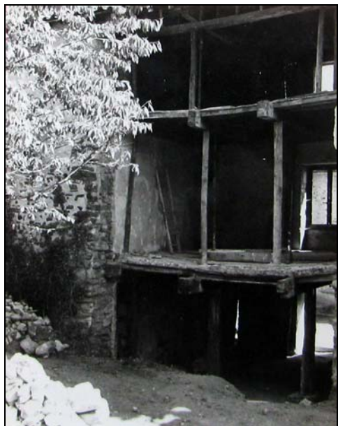
Travaux à Goutelas : calage des murs (document transmis par M. et Mme Païs)
