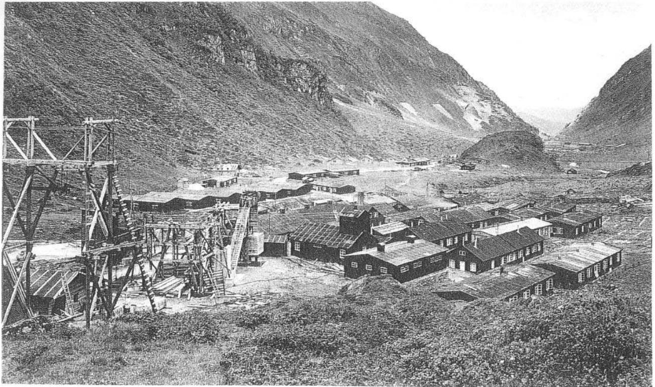
Baustelle Wasserfallboden 1943. Links vor den Baracken ist die Talstation einer Materialeiseilbahn, die Kies vom Mooserboden zum Betonieren der Limbergssperre heranschaffte. Bild: TKW-Arch.
