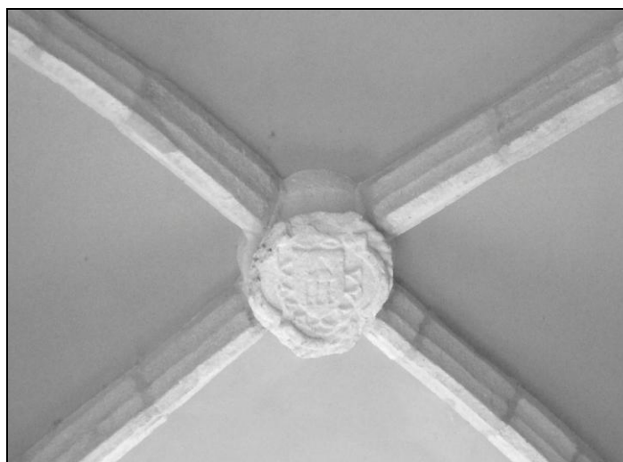
Clé de voûte 95 à la jonction des voûtes sous le clocher
