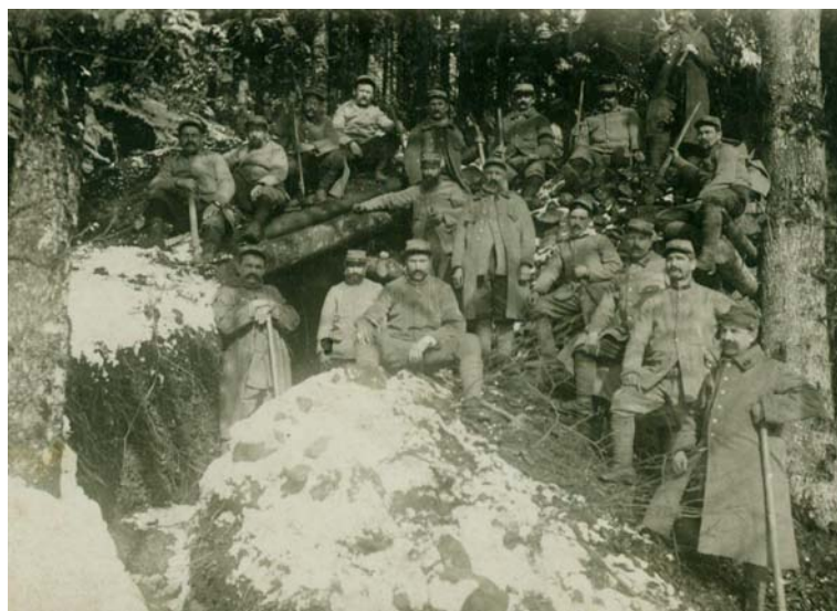
Ces maudites tranchées...
