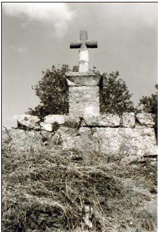
Sur le terrain communal de Contéol-Bas, base de croix en granit, restauration en béton réalisée par M. Brunon.
