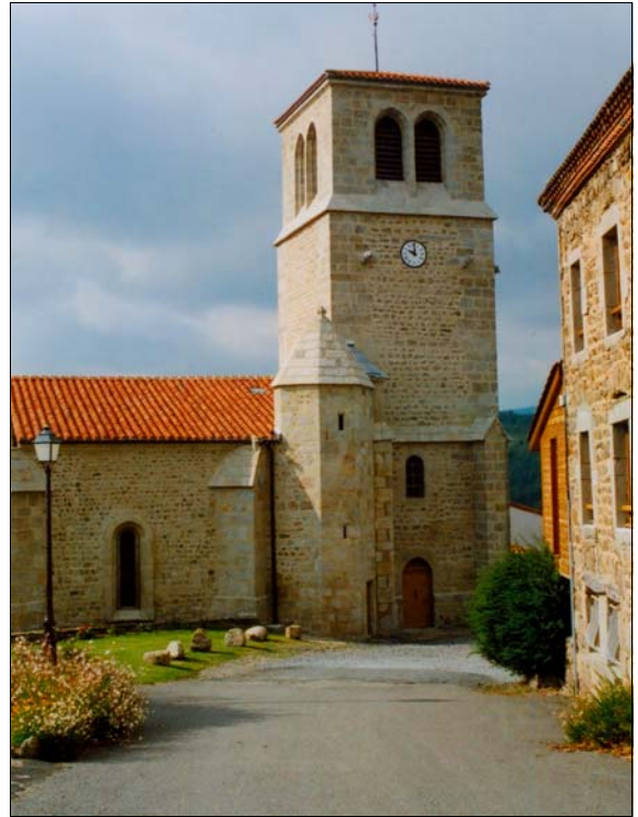
Printemps 2007, après restauration (cliché de l'auteur)
