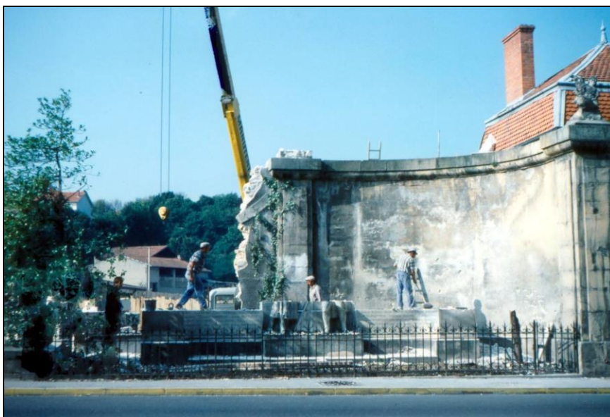
Démontage du monument
