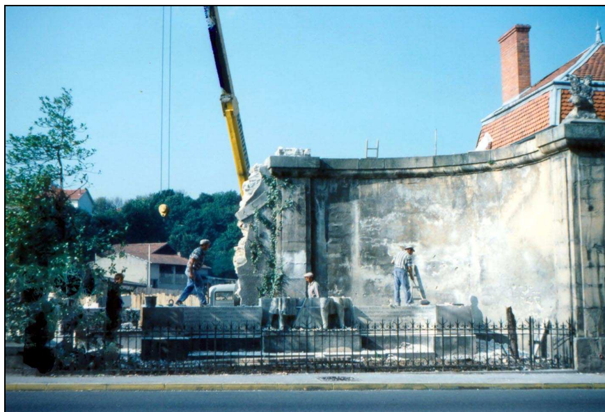
Démontage du monument
