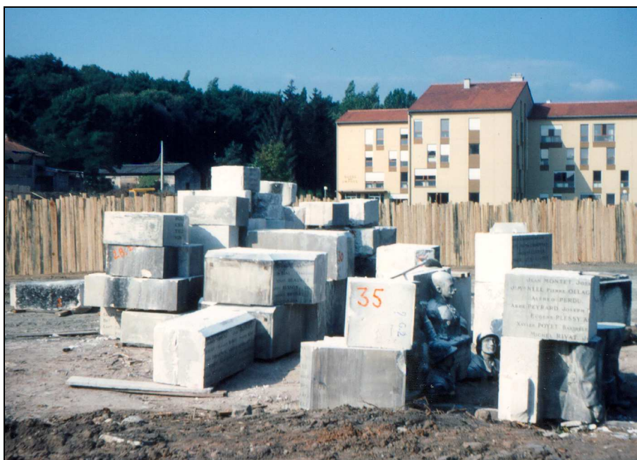
1981 : des blocs de pierre numérotés prêts à partir pour le Jardin d'Allard...
