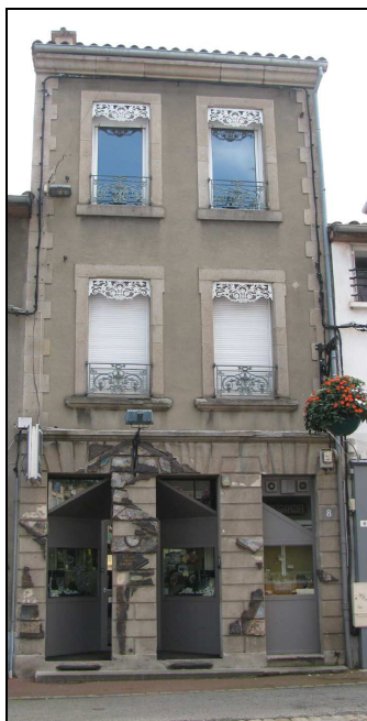
n° 8, rue Tupinerie
