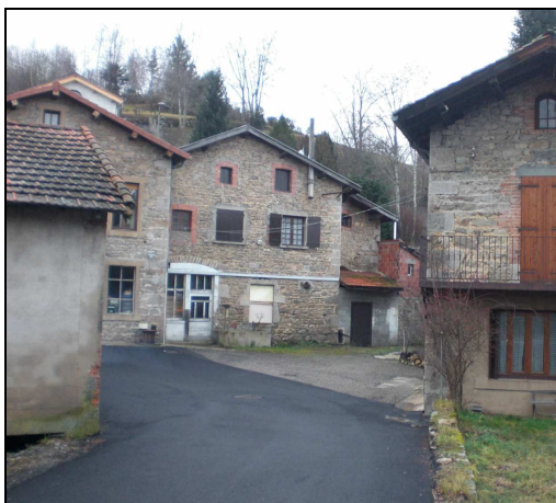
Les bâtiments de la fromagerie à la sortie du village
