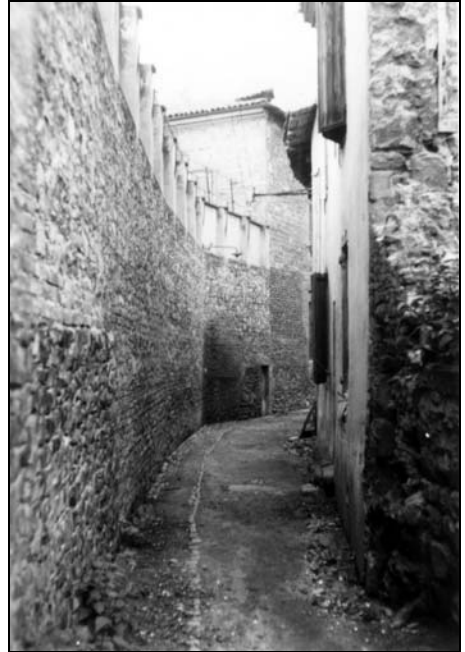
Rue Saint-Aubrin. Chez Blanchard, chez Roche.
