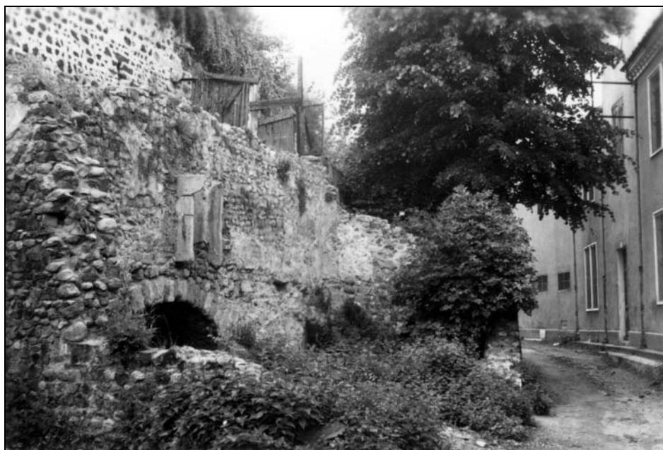
Restes d'une maison effondrée, en face l'arrière de la demeure des Perrichons
