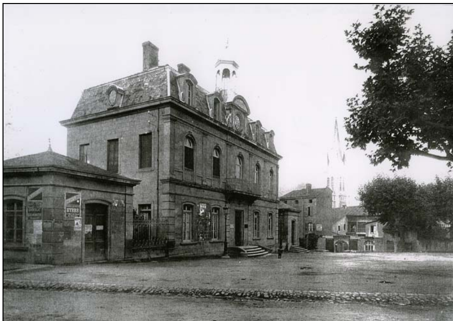
Photo très ancienne : on peut encore voir en arrière-plan la galerie et le porche d'entrée de la Grenette
